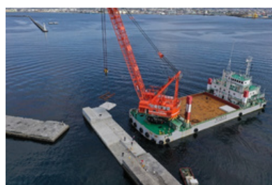
土木 函館港西防波堤
